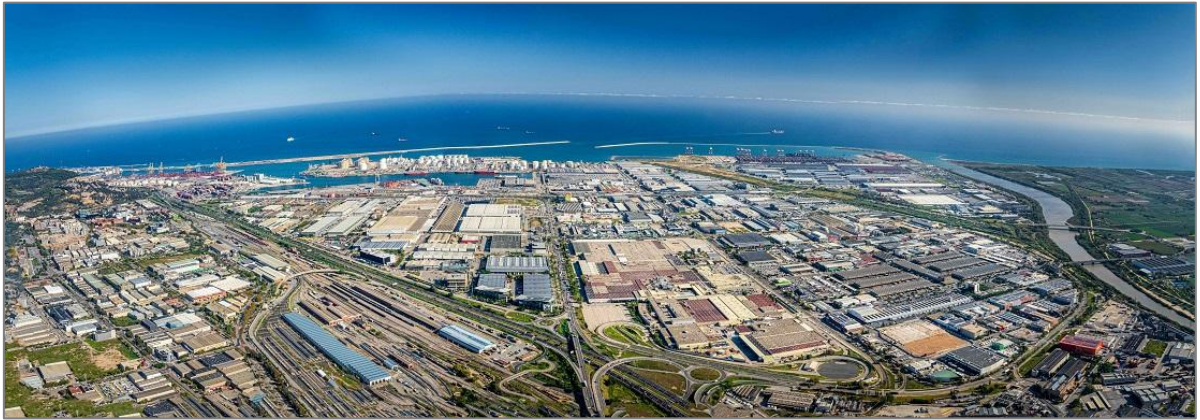
Polígon Industrial Zona Franca Barcelona Font: Consorci Zona Franca Barcelona
